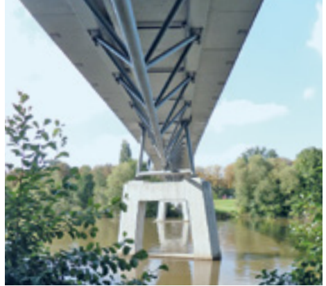
... zur Gärtnerplatzbrücke aus Spezialbeton.
