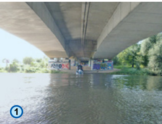
Das gegenüberliegende Ufer der Fulda scheint eine Natur-Slipanlage zu sein.
