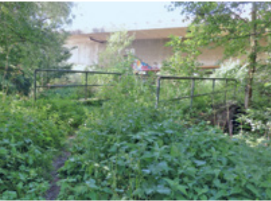
Die Rostbrücke über den „Fuldaweggraben“, hinten die Südtangente über der Fulda.
