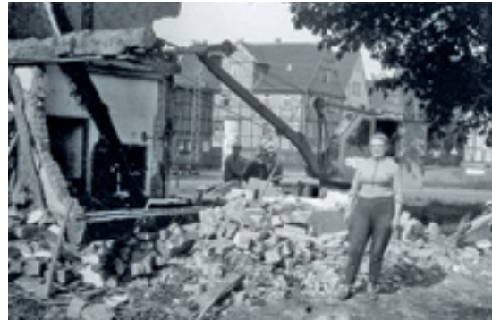
Abriss der alten Schmiede (1960).
