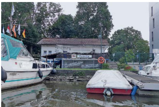
Der Nautic-Club verfügt über eine Slipanlage.
