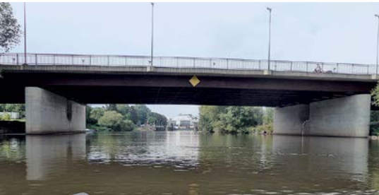
Die 6-spurige Hafenbrücke.
